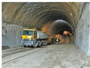
Şəkil 1. Qarabağda inşa olunan tunel
